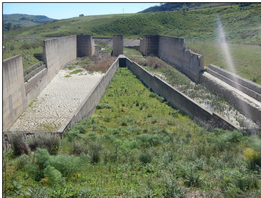
Figura 3-23: Vasca di dissipazione
