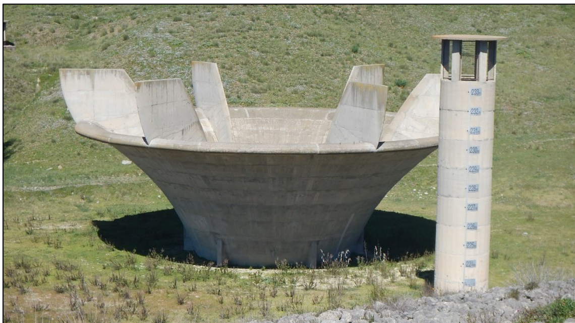
Figura 3-6: Sfiatore a calice sinistro con torrino aeroforo
