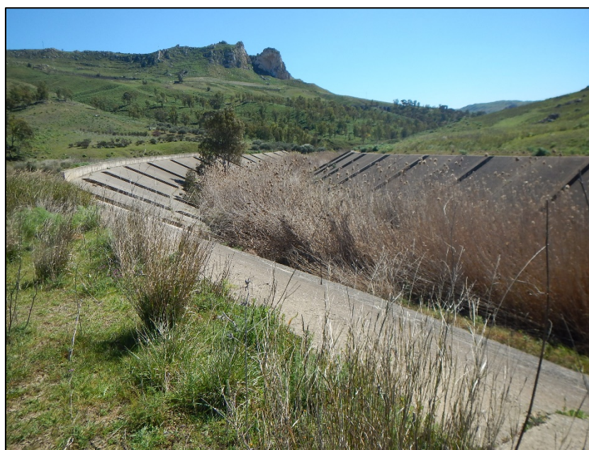
Figura 3-24: Canale di restituzione in alveo
