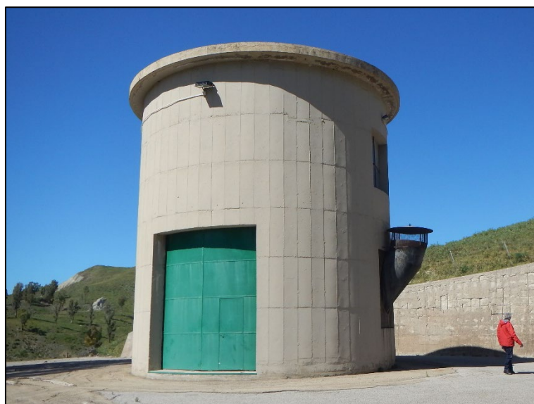
Figura 3-9: Torre paratoie scarico di fondo e derivazione
